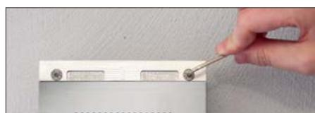
**3** Türstation anschließen und im vorgesehen AP/UP-Gehäuse, Hohlwand oder in der Behnke-säule (nur Serie 5) befestigen. Bei Geräten der Serie 10 die Edelstahlstreifen wieder befestigen.
